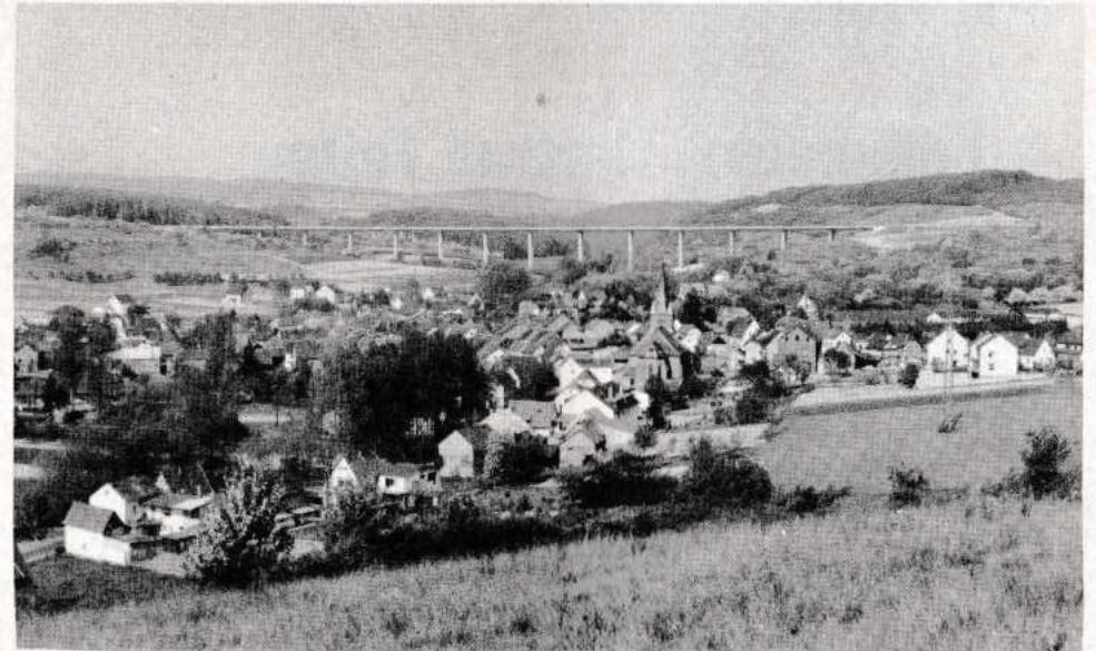
WALDORF im Vinxtbachtal. Die Autobahnbrücke hat das Bild der Landschaft verändert.
